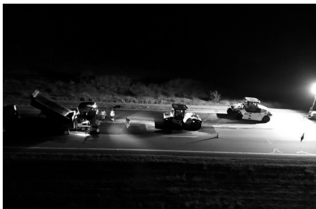
Equipes estão trabalhando inclusive no período noturno nas estradas | Divulgação Renovias
