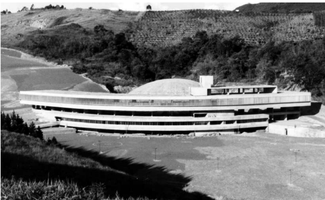
Antigo registro do Centro de Convenções, ainda em obras | Acervo
