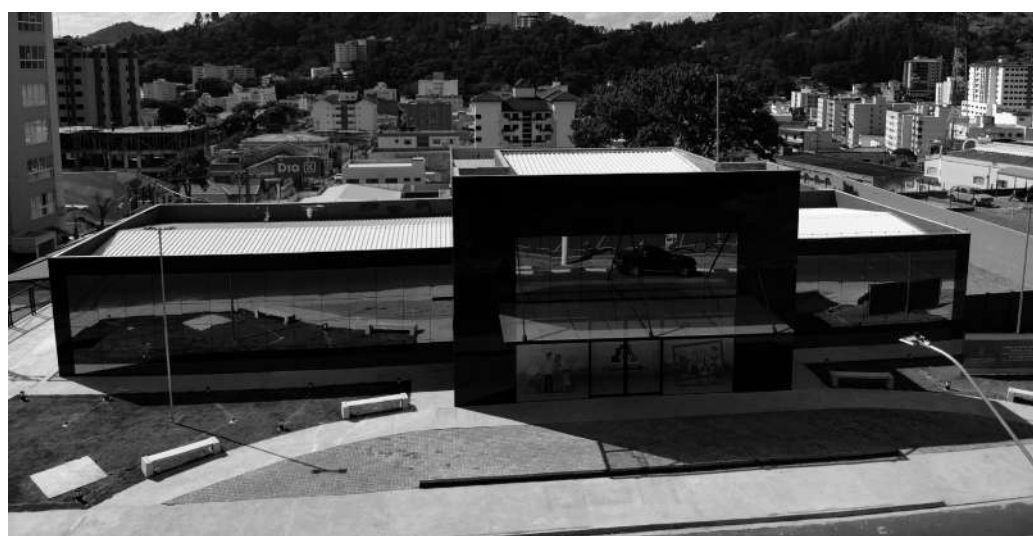
Novo complexo de saúde, que também serve como base do SAMU, possui uma capacidade 30% maior do que o antigo posto, podendo atender milhares de pessoas anualmente | Divisão de Comunicação da Prefeitura de Serra Negra
